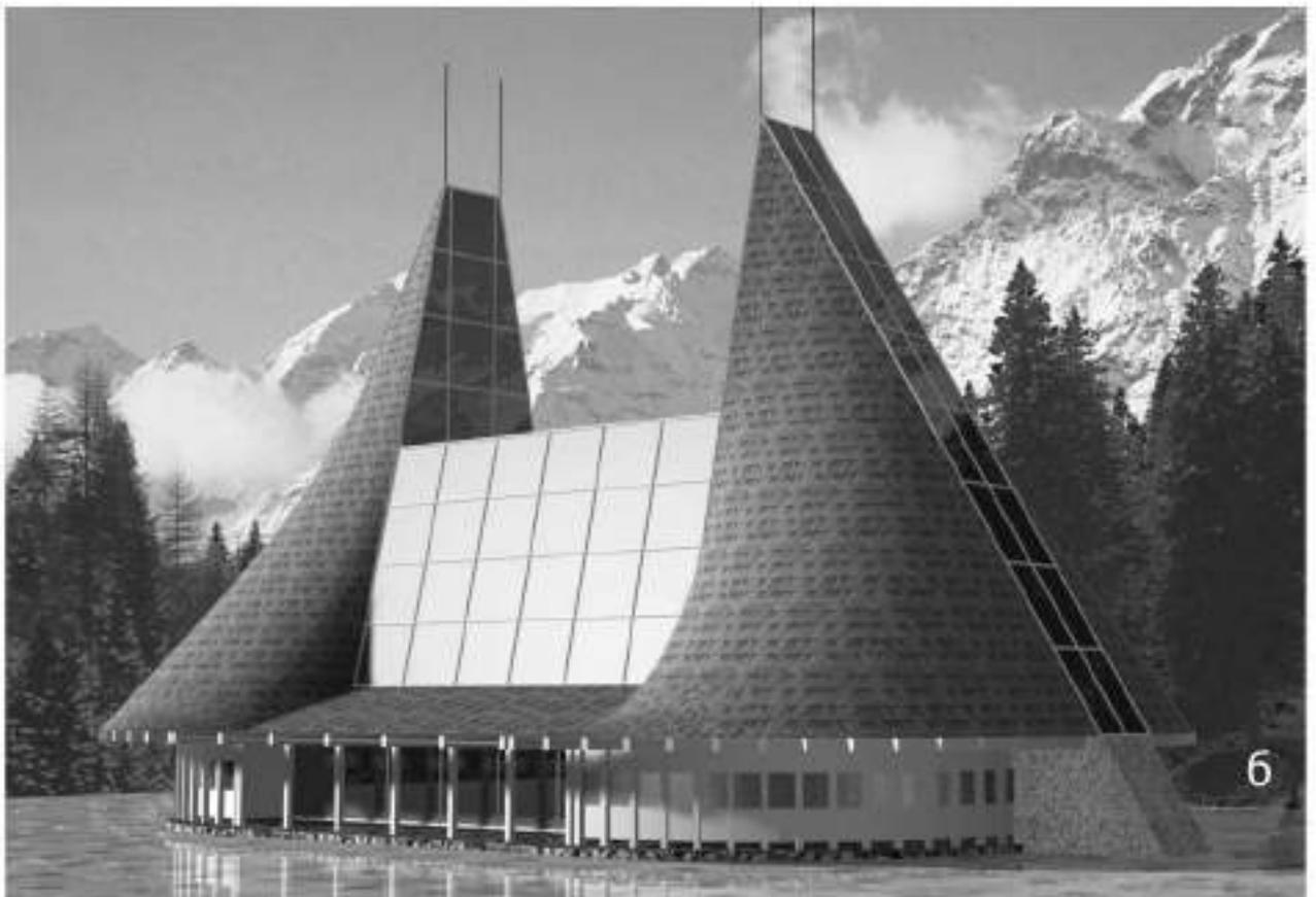
Рисунок 115 - Складчатые оболочки, полностью формирующие дизайн фасадов и покрытий одновременно. Так остроугольная двухскатная оболочка (а) состоит из двух зеркально симметричных складчатых цилиндридов и опирается на основание всего в четырех точках. Многогранные оболочки (б,в) образованы путем переменных усечений и пересечений пирамидальных и призматических объемов. Автор концептов и рисунков Коротич А.В.
